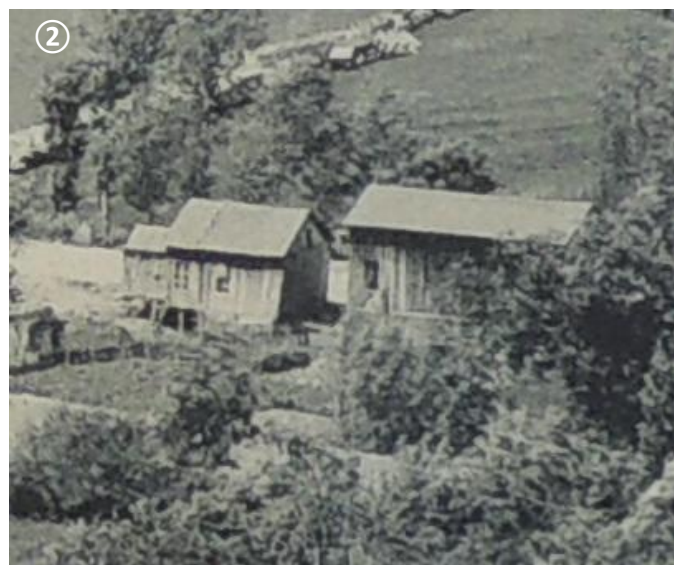
① - Vue du village de Vendes et du Viaduc flambant neuf en 1893. ② - Cambuses en bois à proximité du pont de Vendes. Entreposées dans un pré voisin, on note la présence d'un alignement de bennes renversées servant, sans doute, aux terrassiers.
