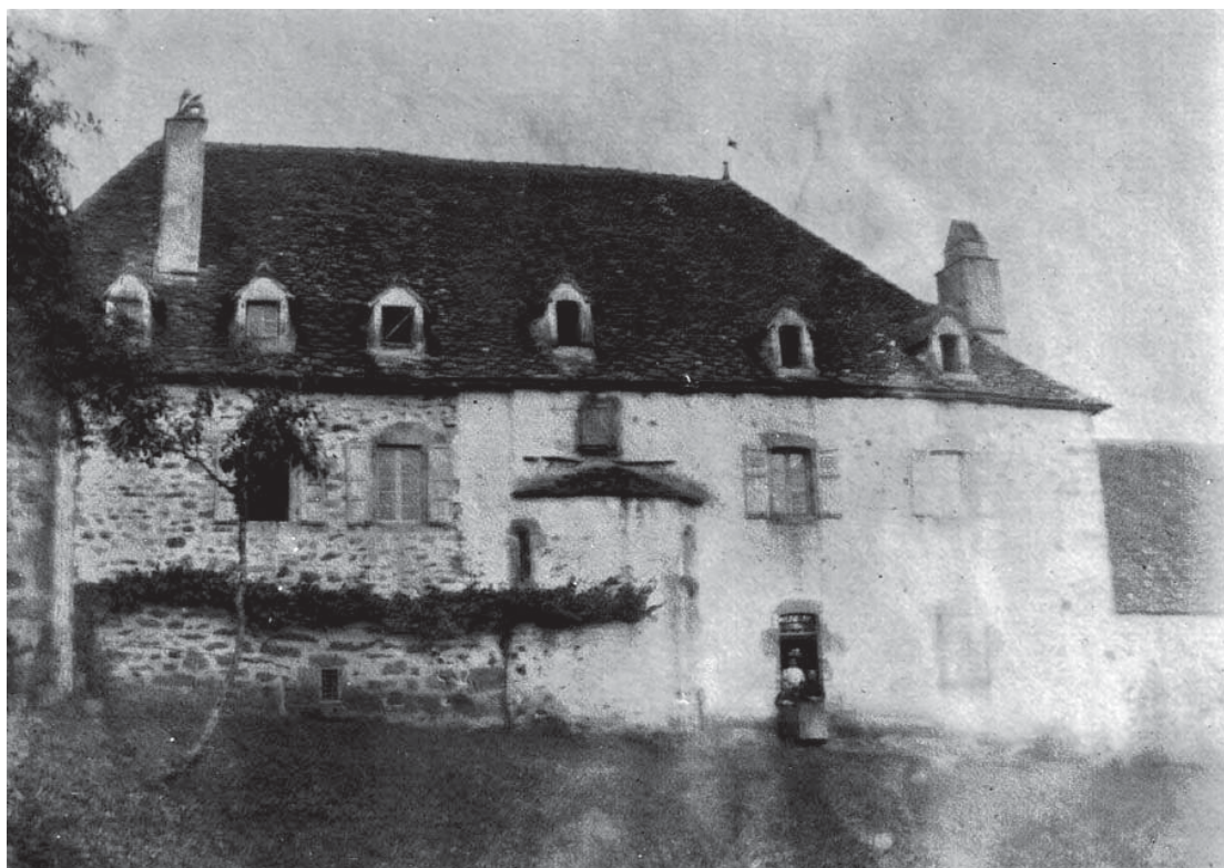
Vue de l'arrière du « château » du Rieu, façade Est. On aperçoit la tour de la chapelle domestique. Cliché non daté, avant 1910.
